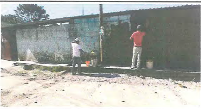
Foto 5: Repello de muro
