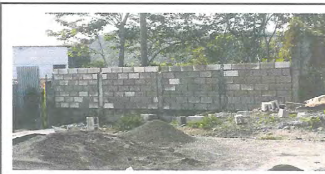
Foto 6: Reparación de muro perimetral
