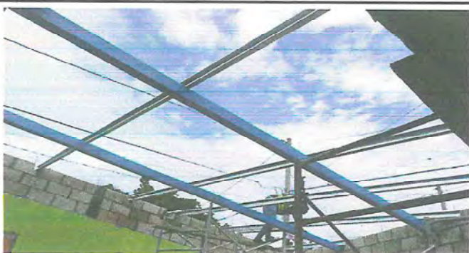
Foto 3: cambio de costanera de metal por metal
