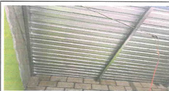
Foto 4: cambio de lamina acanalada por torquelada
